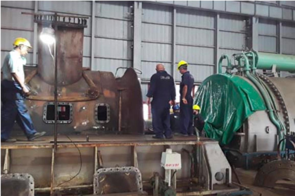
El alineamiento del rotor de baja presión y la rectificación de sus partes y piezas, entre la turbina y el generador, es hoy uno de los trabajos más complejos asumidos en el mantenimiento capitalizable del bloque dos de la **termoeléctrica Lidio Ramón Pérez, en Felton, Mayarí.**
